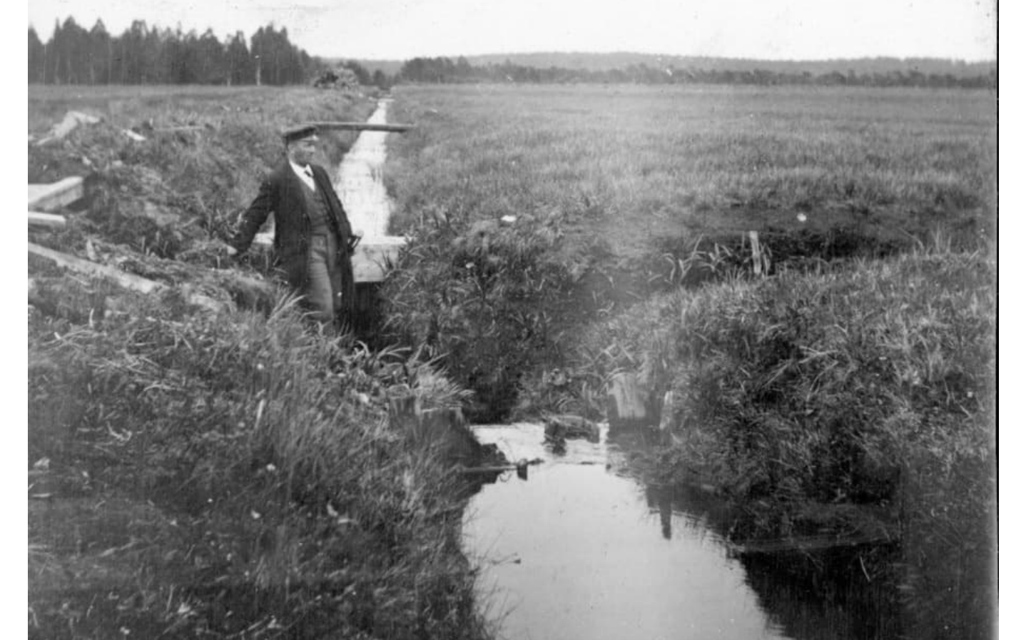
Viemäripatoja (Leteensuu 1920, EAM)
