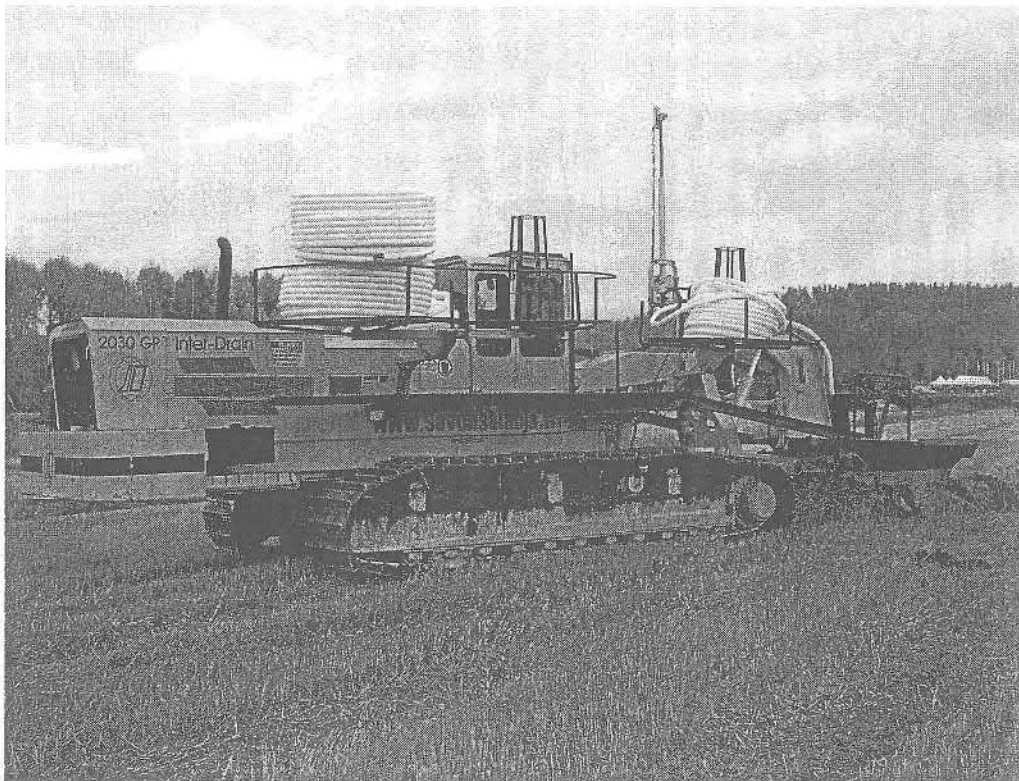
Kuva 8. Esipäällistetyn salaojaputken asennusta. Kuva Hannu Kolehmainen
