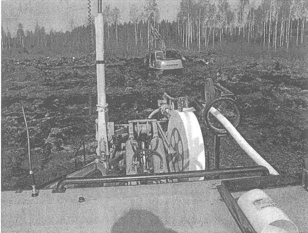
Kuva 7. Aurasalaojakone esipäällystää salaojaputkea. Kuva Hannu Kolehmainen
